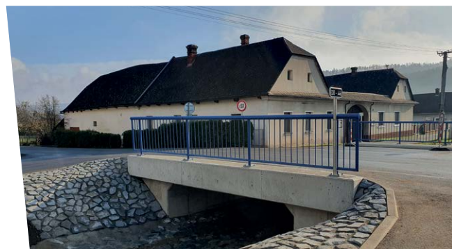
Most ev. č. 644-002 – Pěčíkov po realizaci bridge reg.nr. 644-002 – Pěčíkov (after realization)Architekt
