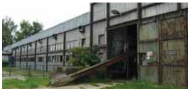
Současný stav objektu Current state of the building
