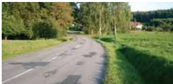
Stávající stav vozovky Current condition of the road
