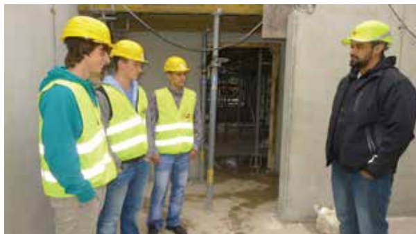
Odborná stáž u Stavební firmy Ječmínek, spol. s r.o. Internship in Stavební firma Ječmínek, spol. s r.o.
