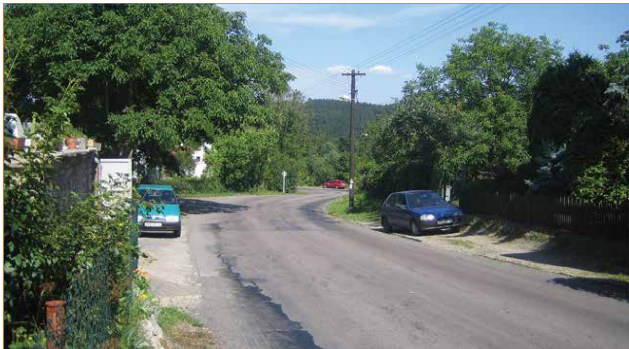
Silnice II/315 Hrádek- průtah před realizací
