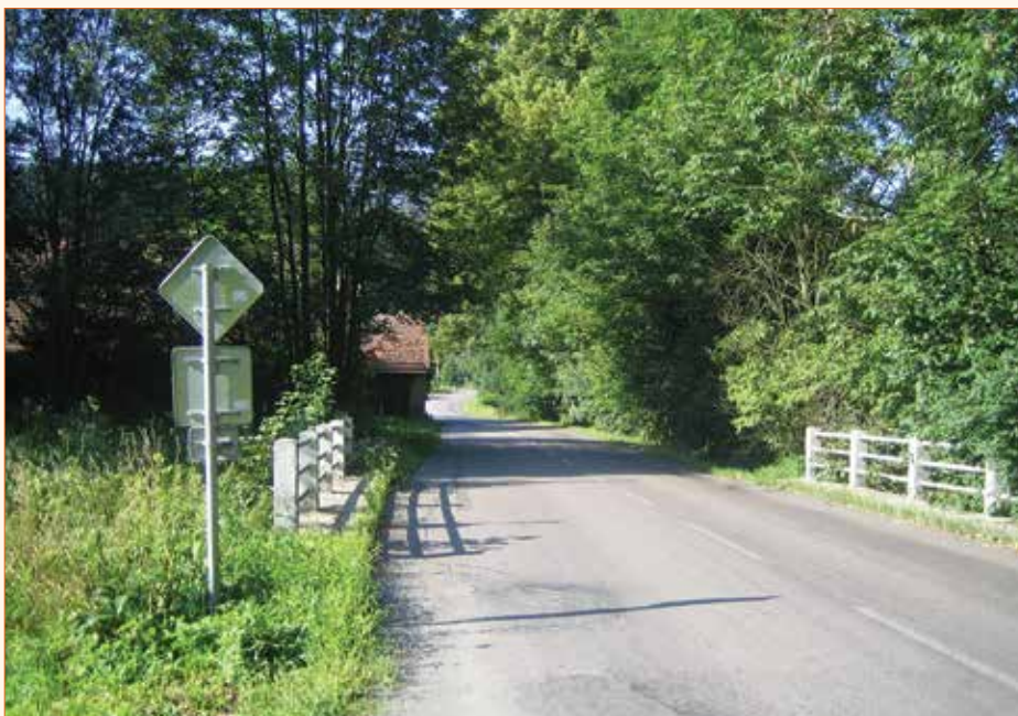
Silnice II/315 Hrádek - průtah po realizaci / The road II/315 Hradek - prutah after realization
