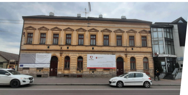
Nové sídlo P-PINKu v ulici Jana Palacha v Pardubicích (před rekonstrukcí) New P-PINK head office at Jana Palacha street in Pardubice (before reconstruction)
