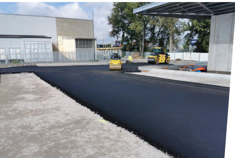
Průběh stavebních prací na novém Terminálu B Construction works at the new Terminal B
