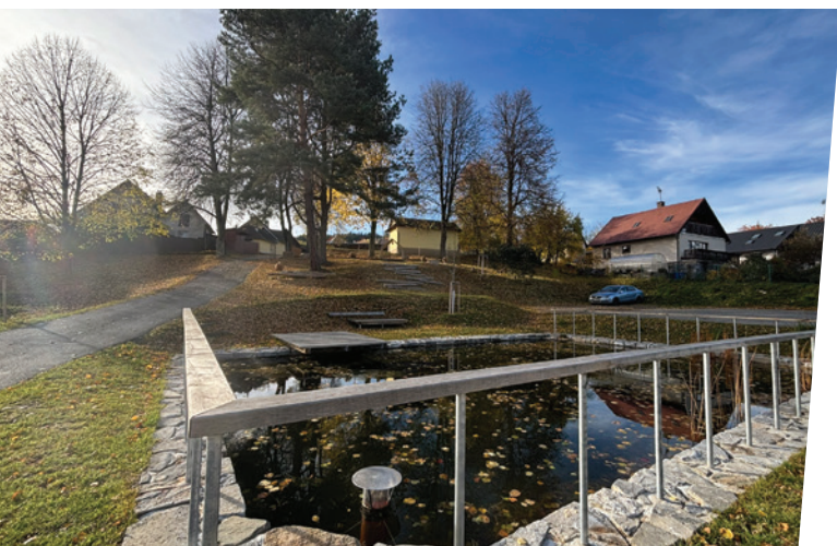
Revitalizace veřejného prostranství v okolí kulturního domu v obci Trpín Revitalisation of the public space around the cultural centre in the municipality of Trpín
