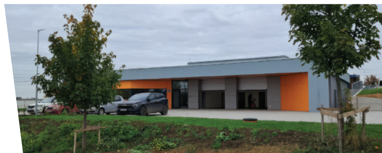
Výstavba nové výjezdové základny Zdravotnické záchranné služby Pardubického kraje v Litomyšli / Construction of a New Ambulance Station for the Emergency Medical Services of the Pardubice Region in Litomyšl
