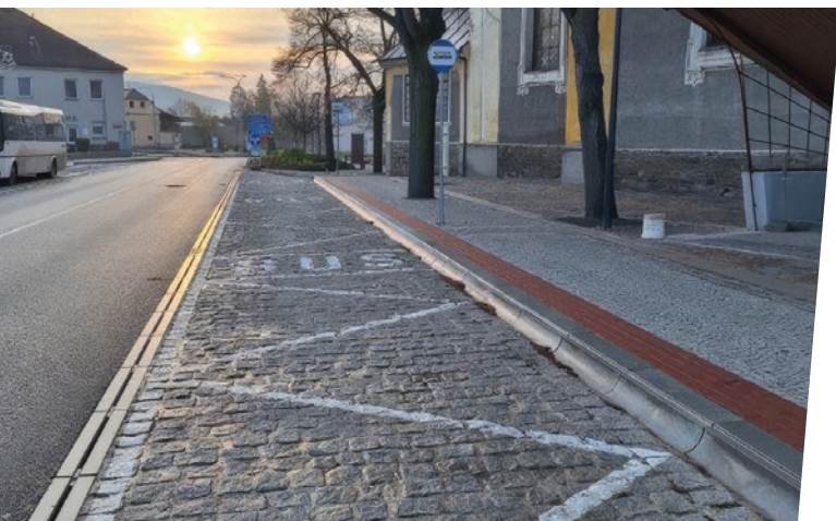
Modernizace silnice II/337 Třemošnice Modernisation of road II/337 Třemošnice
