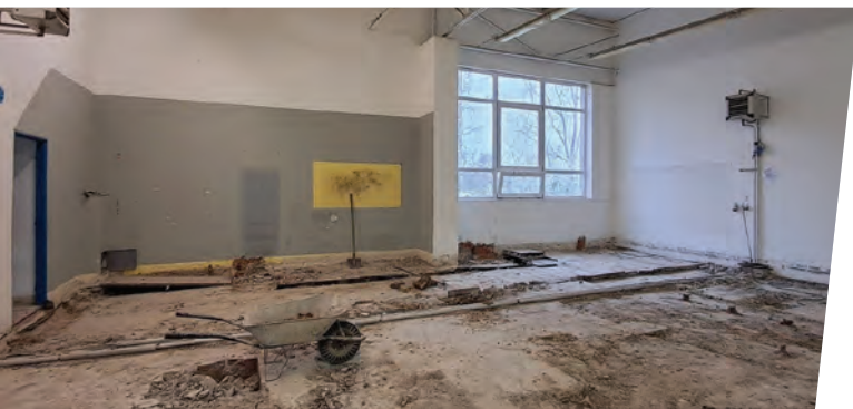
Stavební práce na modernizaci nízkoprahového zařízení pro děti a mládež Naděje Česká Třebová / Construction work during modernization of low-threshold facility for children and youth Naděje Česká Třebová
