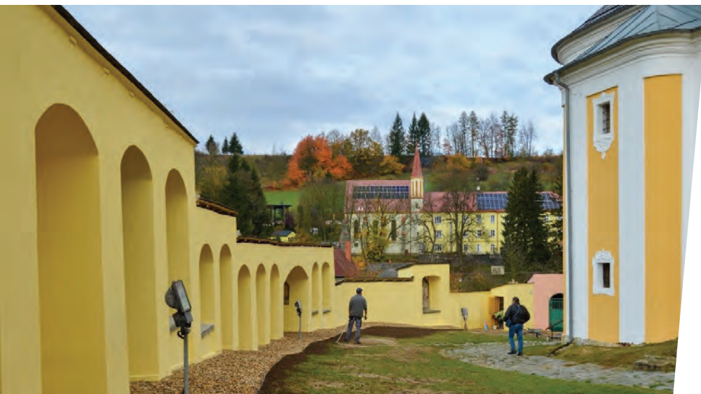
Opravená zeď u kostela v Koclířově Renovated wall around the church in Koclířov
