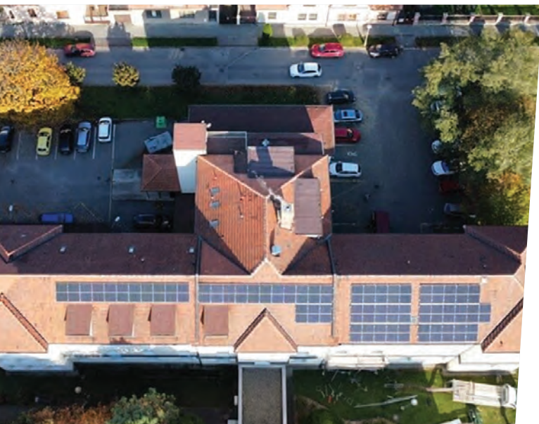
Fotovoltaika na budově Vysokomýtské nemocnice Photovoltaics on the building of Vysoké Mýto Hospital
