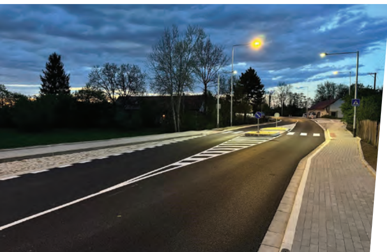
Modernizace silnice II/324 Staré Hradiště – Hrobice Modernization of road II/324 Staré Hradiště – Hrobice
