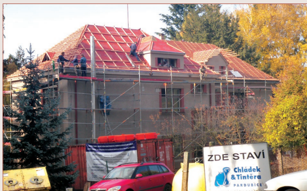
Rekonstrukce „lékařské vily“
