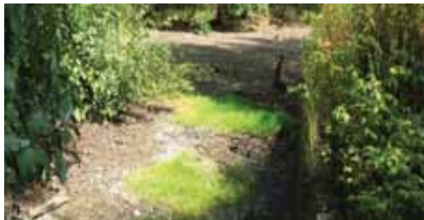
Západní výběžek kalového pole u příjezdové cesty na skládku West part of the sludge bed next the access road to the landfill
